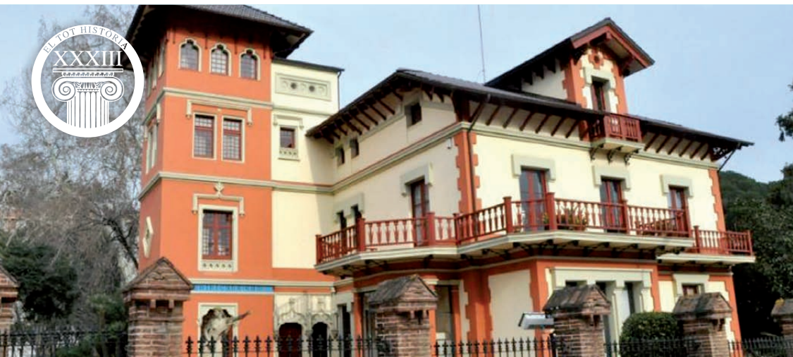
□ CA L'ALFARO (EDIFICAT A PRINCIPIS DEL SEGLE XX) ÉS UN DELS EDIFICIS MÉS EMBLEMÀTICS DE SANT ANDREU DE LLAVANERES
