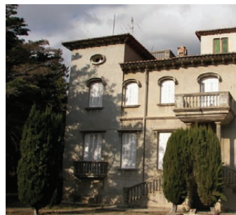
La zona de la Raureta.
